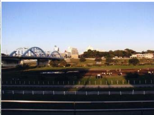
写真 多摩川河川敷と丸子橋
